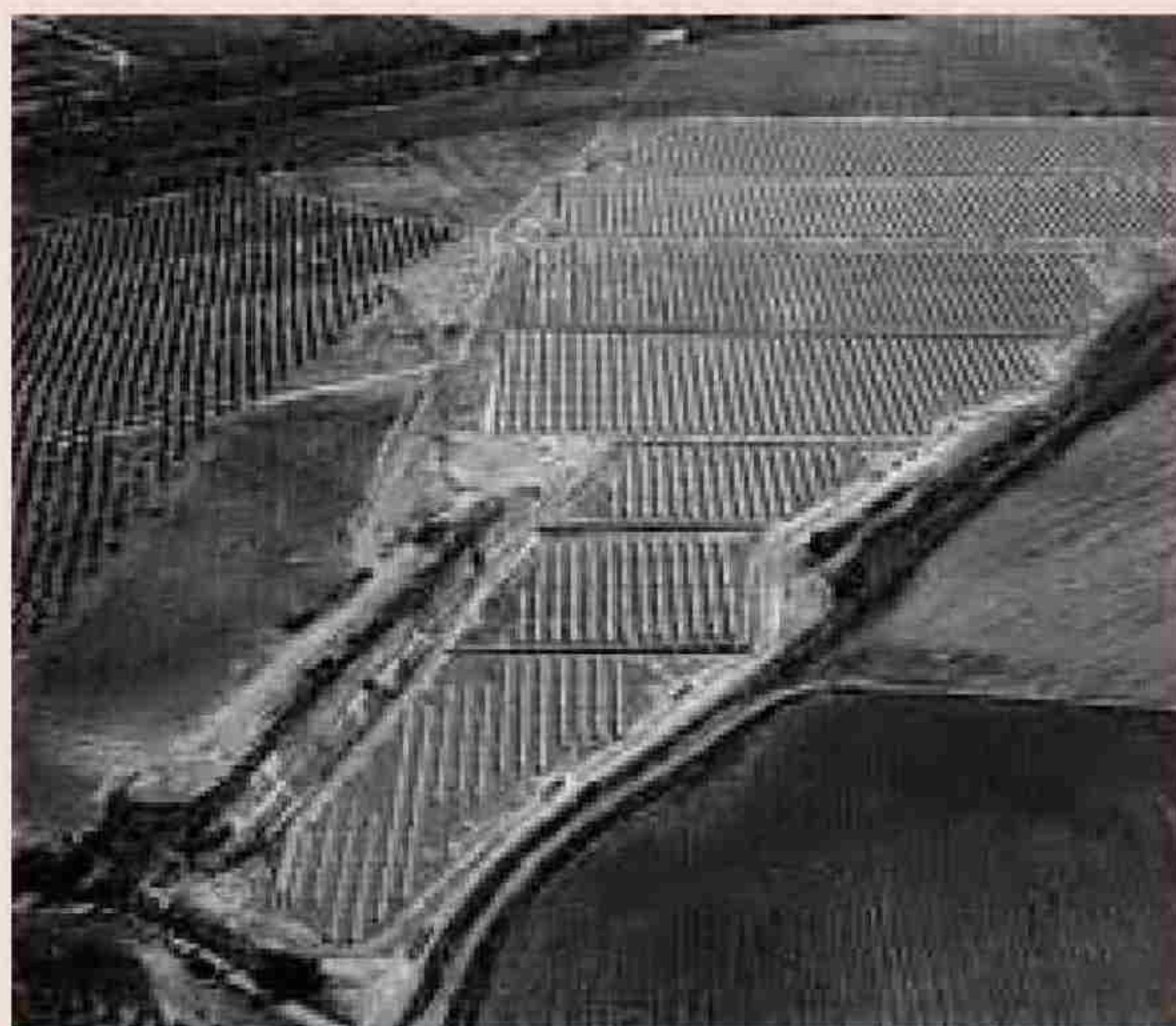
Planta fotovoltaica El Carpio, propiedad de Grupo Montealto.
